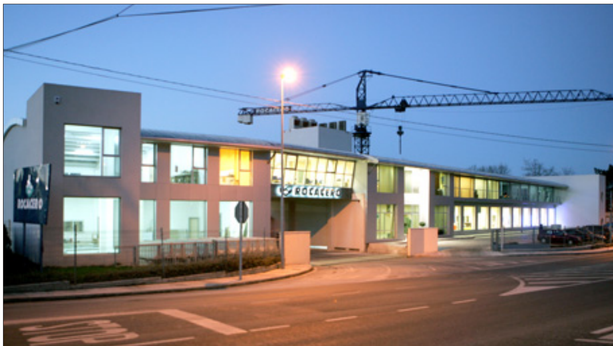
Nuevas instalaciones de Rocacero en Requejada.
